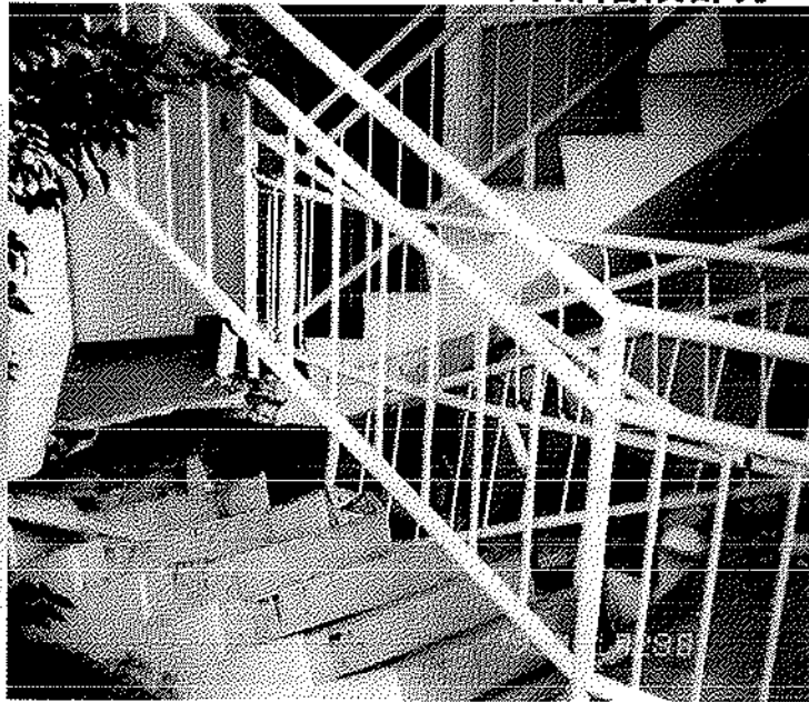
外部階段部分
